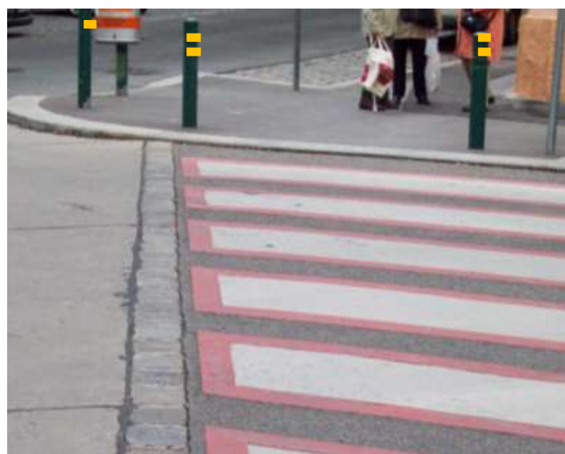
Bild 17: Beispiel: abgesenkter Übergang mit Leitlinie
