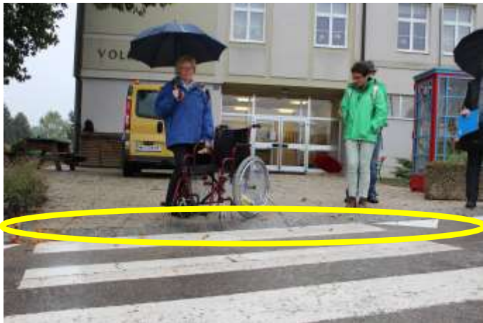
Bild 14: Zu steile Absenkung
