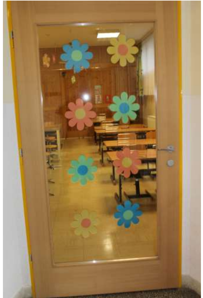
Bild 11: Glasmarkierung in der VS
