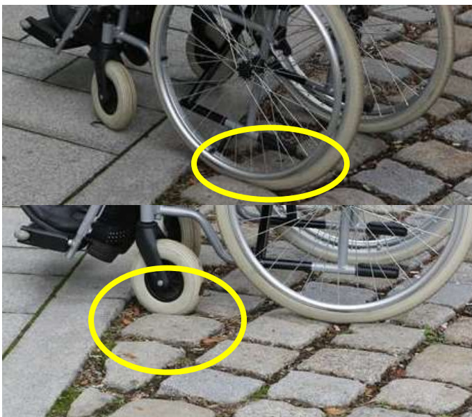
Bild 12: Beispiel - Pflastersteinflächen als Reifenfalle
